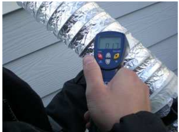
Medición de temperaturas a lo largo del tubo
