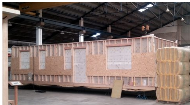
Muro exterior con SATE (Sistema de Aislamiento Térmico Exterior)
